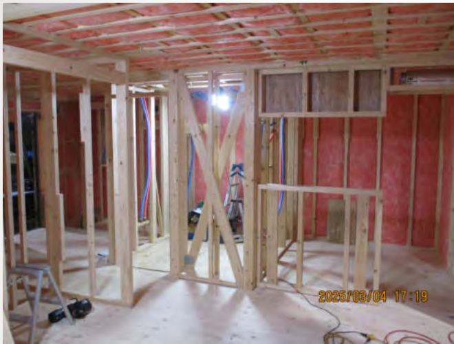
UB前 廊下体力壁（合わせ部）
