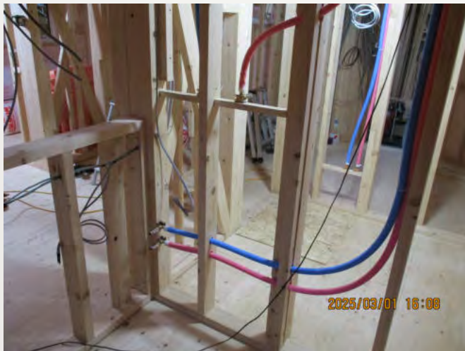
2 次側 電気・給水配管
